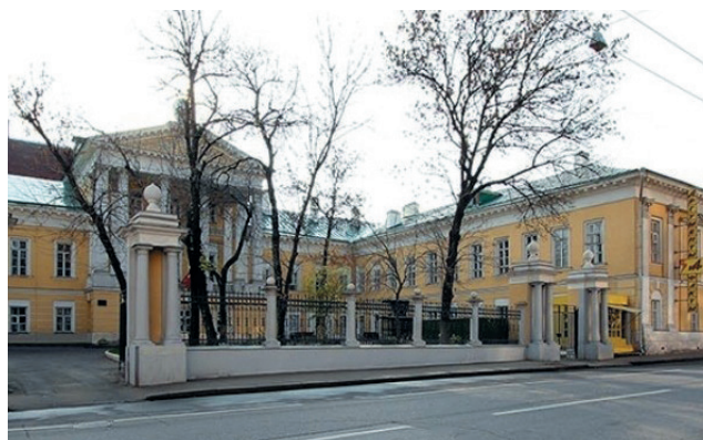
Рис. 6. Усадьбы Барышникова на Мясницкой, 42 (на фотографии общий вид здания, 2017 г.)
